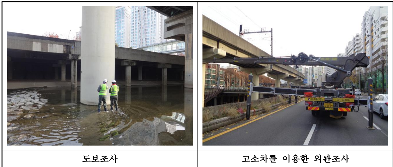
【사진 I -3.1】외관조사 전경
